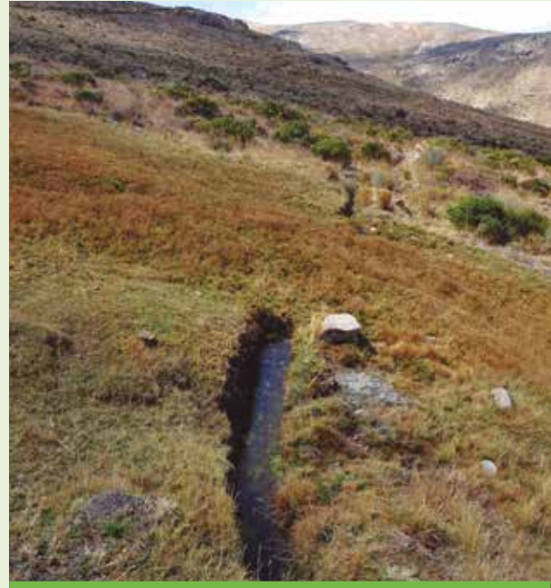
Siembra de agua o “amuna”: zanjas de infiltración llenas con agua en Tupicocha, Huarochirí. Similar tecnología habrían empleado en la época de Caral.
