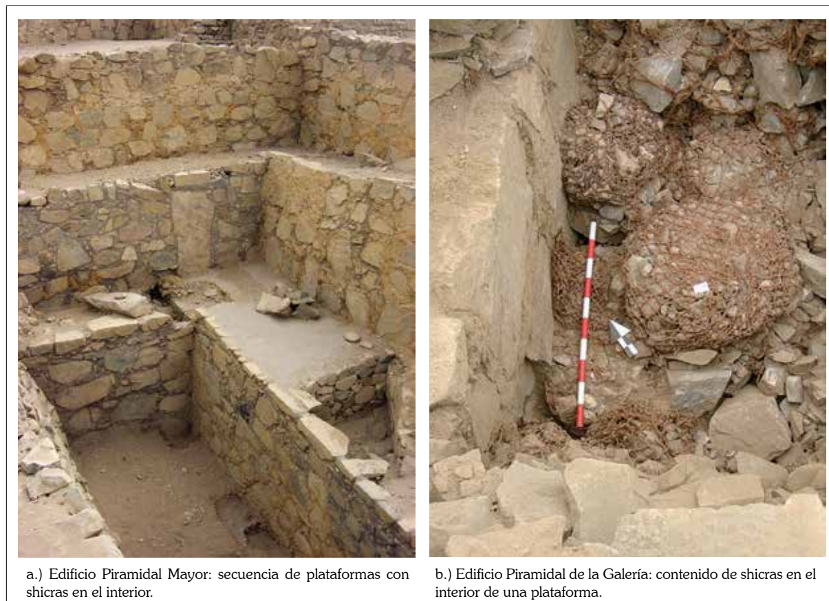
Figura 31. Tecnología sismorresistente aplicada en la construcción de los edificios piramidales: Secuencia de plataformas en cuyo interior se depositaron piedras contenidas por bolsas de fibra vegetal, «shicras».
