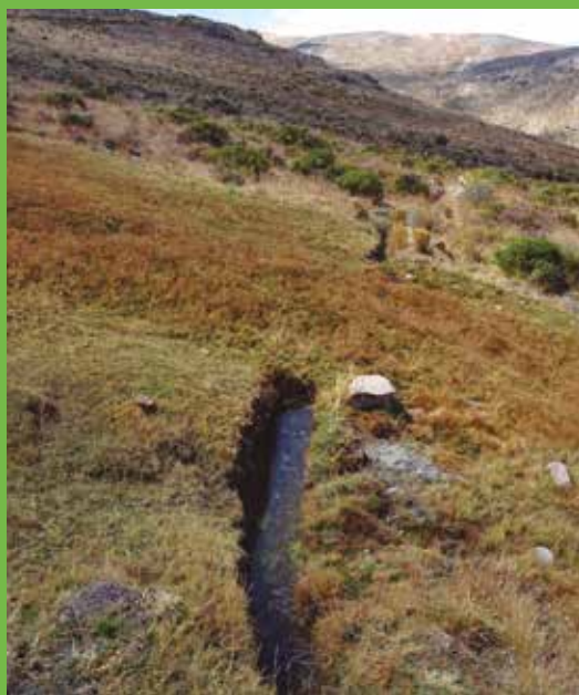
Siembra de agua o "amuna": zanjas de infiltración llenas con agua en Tupicocha, Huarochirí. Similar tecnología habrían aplicado en la civilización Caral.
